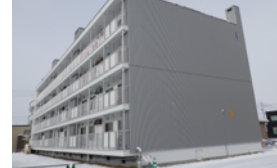
名寄社宅159号ほか 1棟外壁改良他
