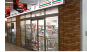
セブンイレブン北海道ST 釧路店新装工事
