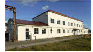
釧路現業事務所 12号内外装改修他
