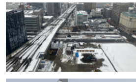
北海道新幹線 札幌駅創成工区
