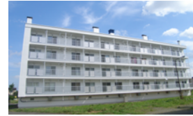
滝川社宅103号改修
